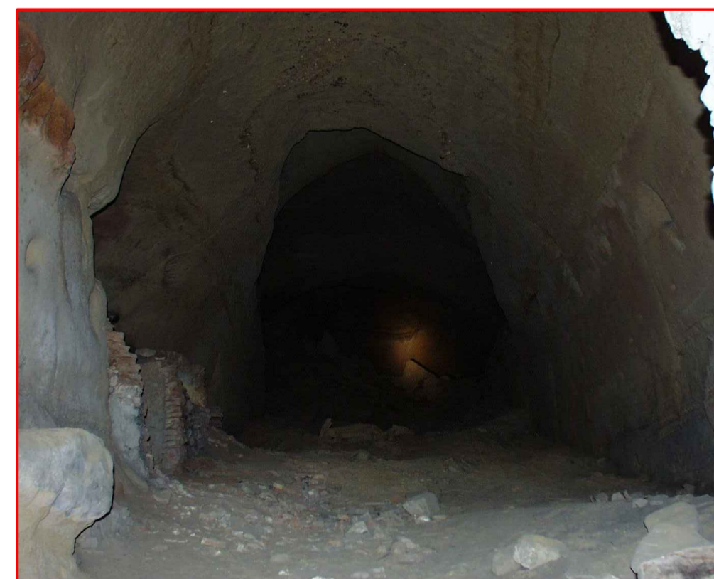
Profondità del cunicolo sinistro.
