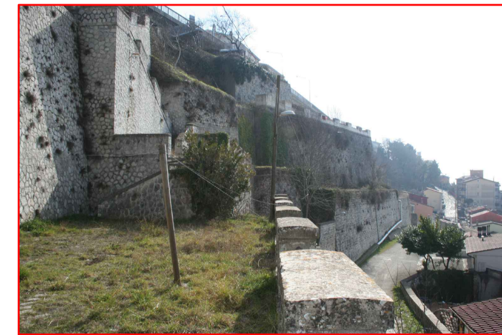
I muraglioni Tranesi dietro i quali sono conservate le fornaci.
