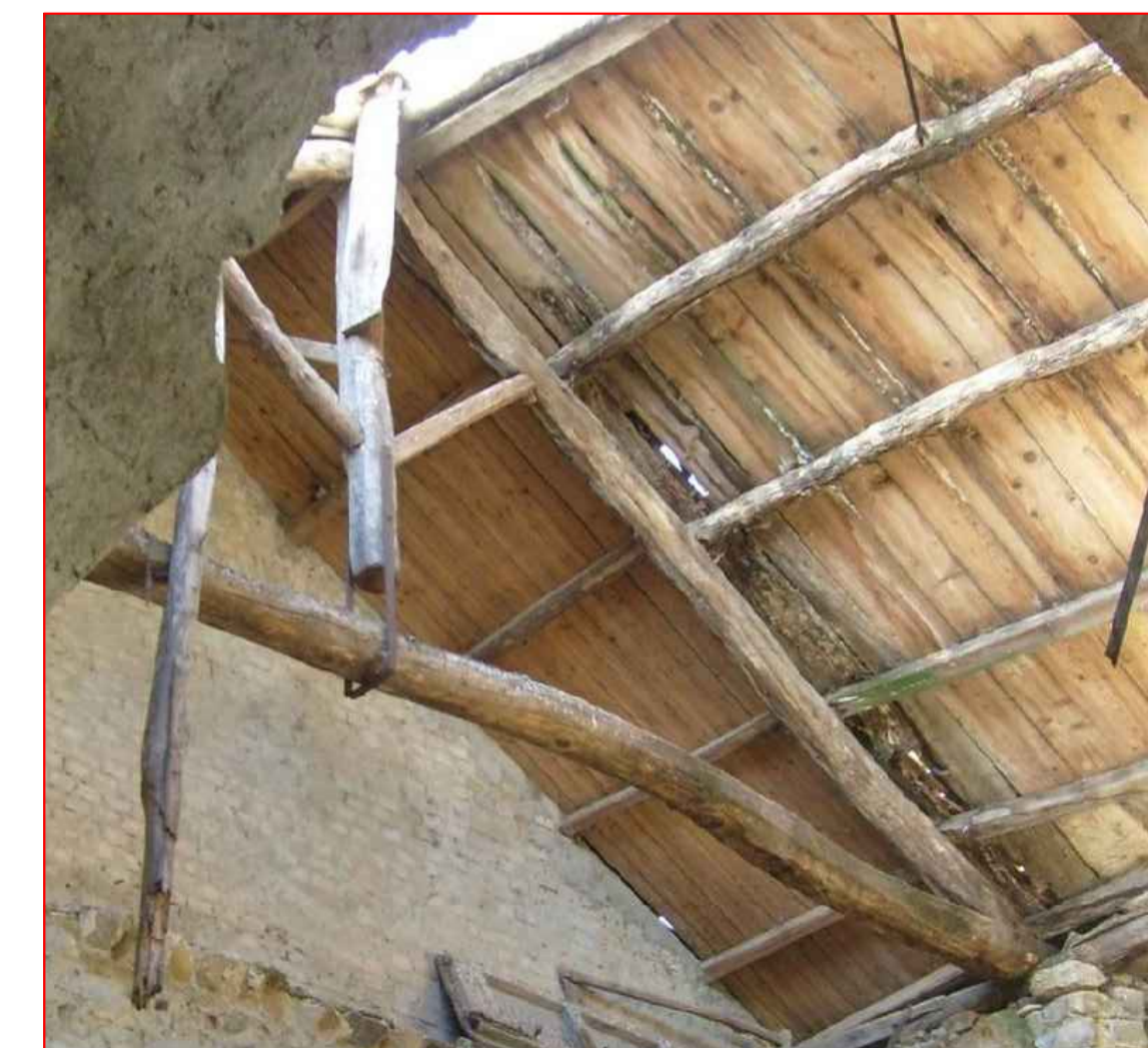
Particolare dell'appoggio del monaco sulla catena.
